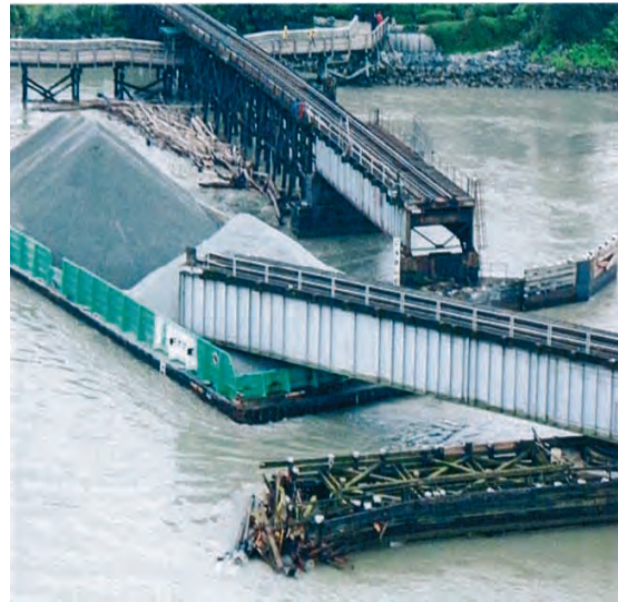
Photo 5. Chaland Empire 40 et pont ferroviaire Queensborough après la collision
