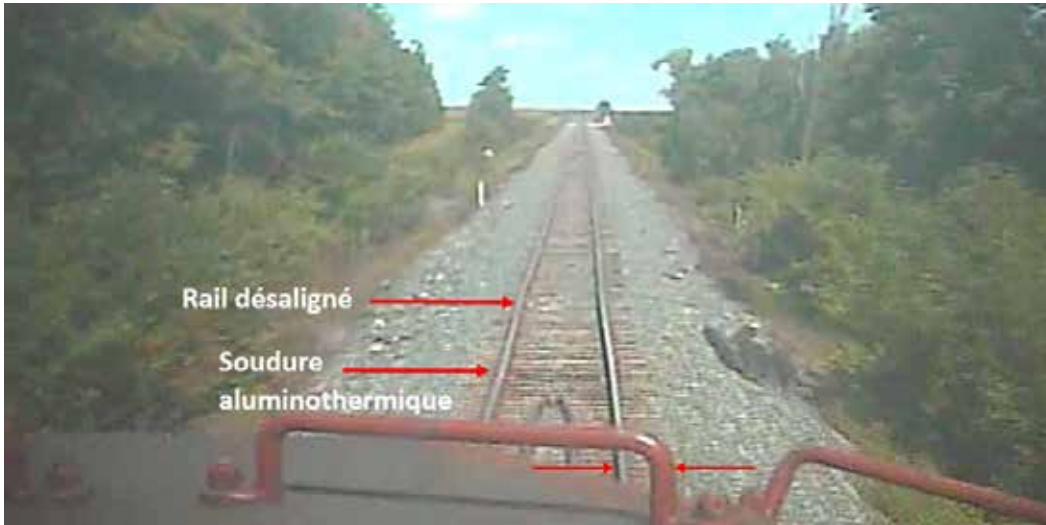
Figure 6. Léger désalignement du rail juste au nord de la soudure aluminothermique (Source : Chemin de fer Canadien Pacifique, avec annotations du BST)
