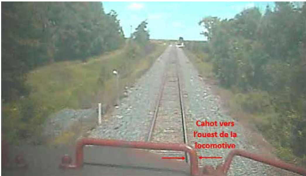
Figure 7. Cahot vers l'ouest de la locomotive à l'emplacement du désalignement du rail ouest, avec des flèches mettant en évidence le déplacement, comparativement à la figure 6 (Source : Chemin de fer Canadien Pacifique, avec annotations du BST)
