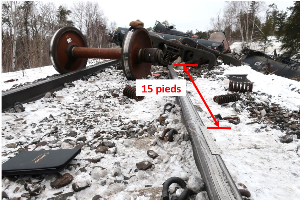
Figure 6. Rail nord rompu à 15 pieds de la marque de roue sur le dessus du rail (Source : BST)
