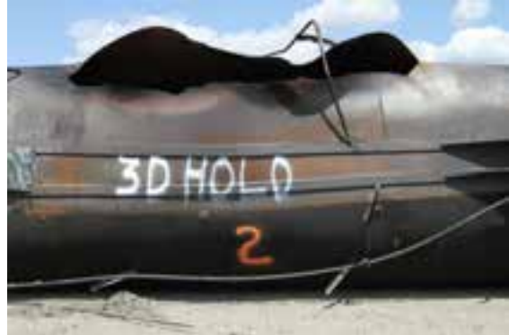
(d) Close-up of thermal tear in shell
