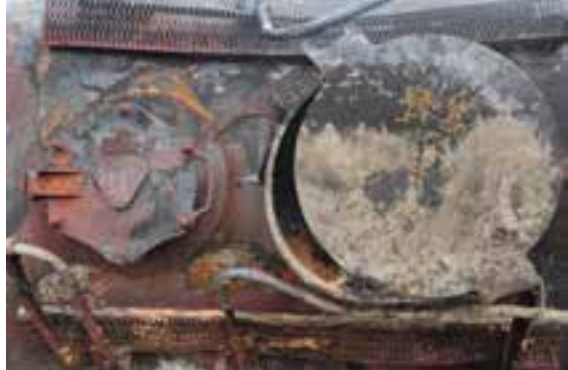
(d) Manway and top fittings
