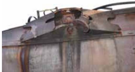
(d) BOV (RSI-AAR Safety Project photo)
