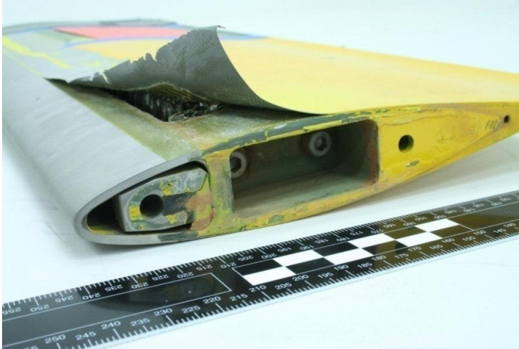
Figure 3. Décollement du joint (Source : Rapport d'enquête AO-2009-002 de l'Australian Transport Safety Bureau)
