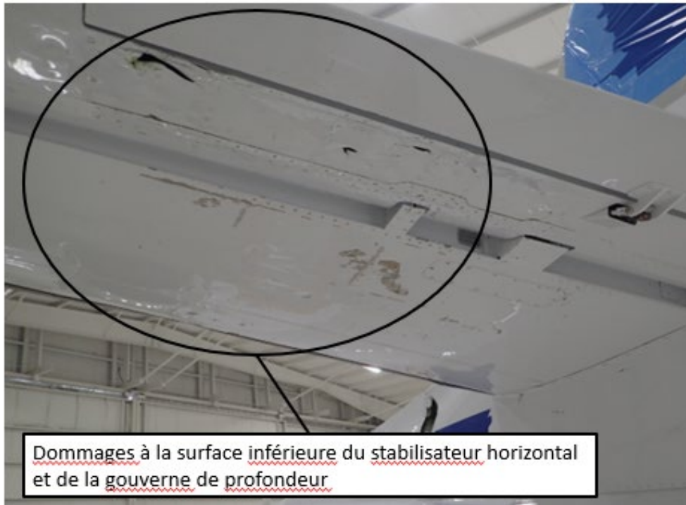
Figure 4. Photo montrant les dommages causés à la surface inférieure du stabilisateur horizontal gauche et de la gouverne de profondeur (Source : BST)
