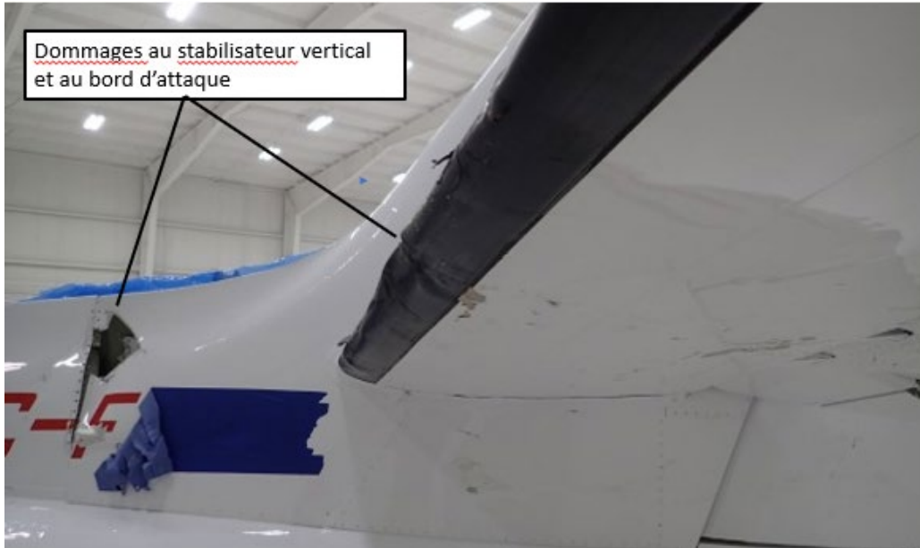
Figure 3. Photo montrant les dommages causés au stabilisateur vertical et au bord d'attaque du stabilisateur horizontal gauche (Source : BST)
