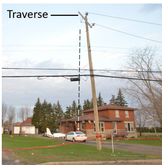
Figure 1. Poteau électrique et traverse, avec une ligne pointillée montrant l'angle du poteau par rapport à la voiture (Source : BST)
