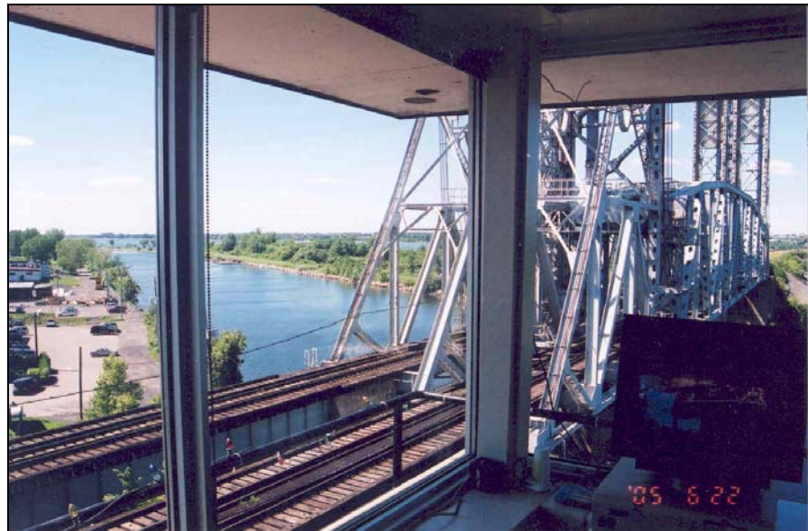
Photo 2. Vue des ponts 7A et 7B depuis la tour de contrôle
