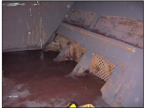
Photo 5. Tôles filtres dans la partie arrière bâbord de la cale
