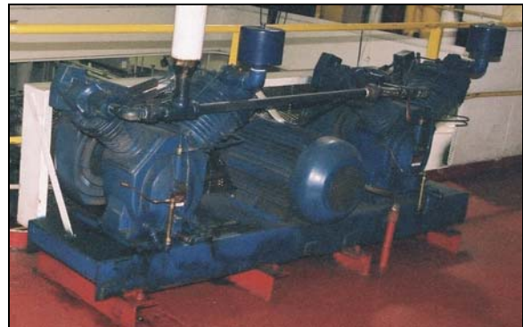
Photo 14. Installation du groupe compresseur montrant le moteur électrique entre les deux compresseurs.
