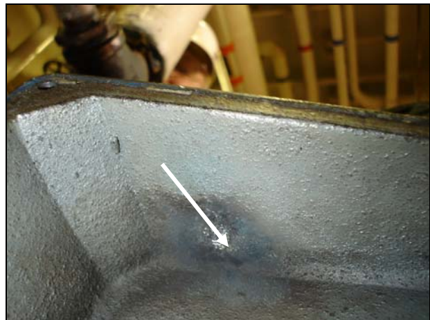
Photo 16. Point de contact à l'intérieur de la partie supérieure du boîtier de connexion.
