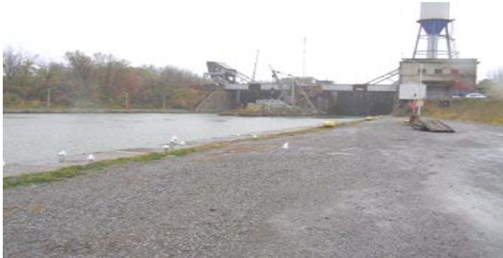
Photo 3. Vue en amont de l'écluse 4 (en direction de l'écluse 5)
