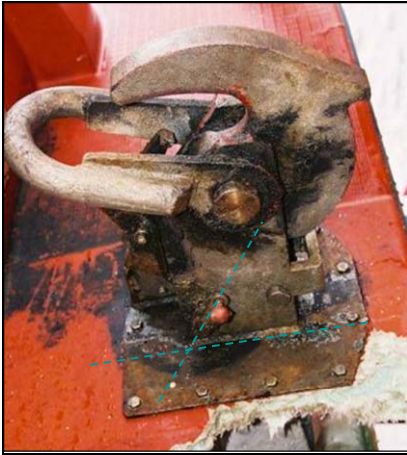
Photo 6. Le levier de la came de verrouillage du croc arrière (bouton rouge) n'est pas à sa position horizontale de réarmement
