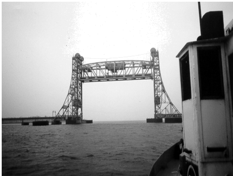
Pont St-Louis en position ouverte
