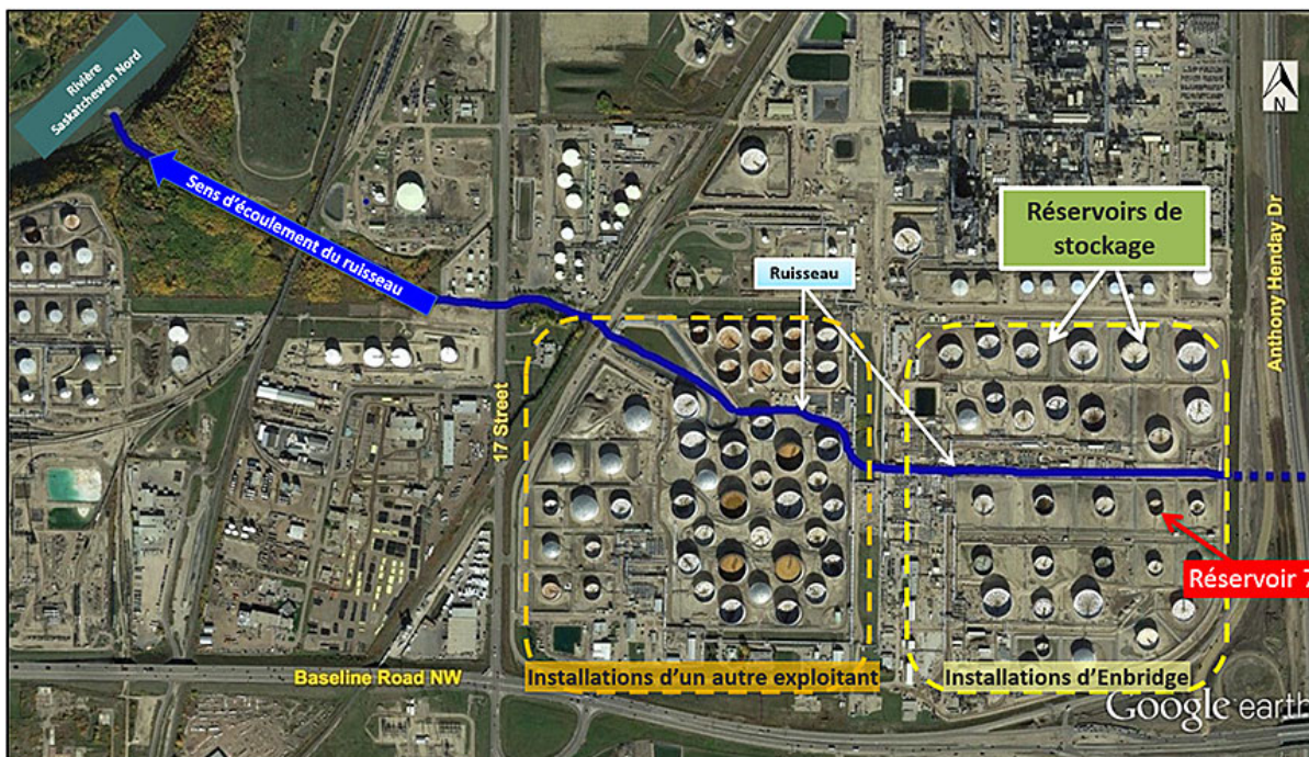
Figure 2. Ruisseau traversant le terminal Edmonton North et se jetant dans la rivière Saskatchewan Nord (Source : Google Earth, avec annotations du BST)
