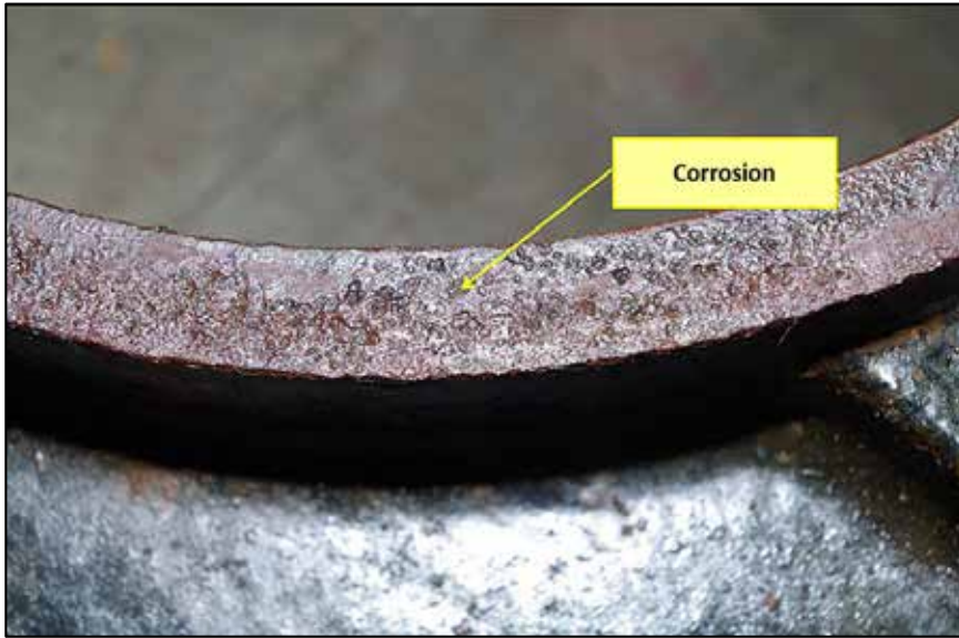
Figure 10. Corrosion sur le siège de la vanne (Source : Acuren Group Inc., avec annotations du BST)
