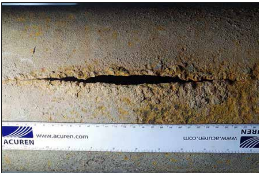
Figure 12. Rupture le long du joint longitudinal soudé (Source : Acuren Group Inc.)
