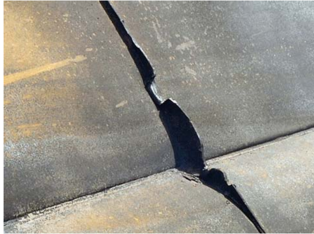
Photo 2. Marques laissées par un champignon de rail sur le déflecteur du réservoir de carburant
