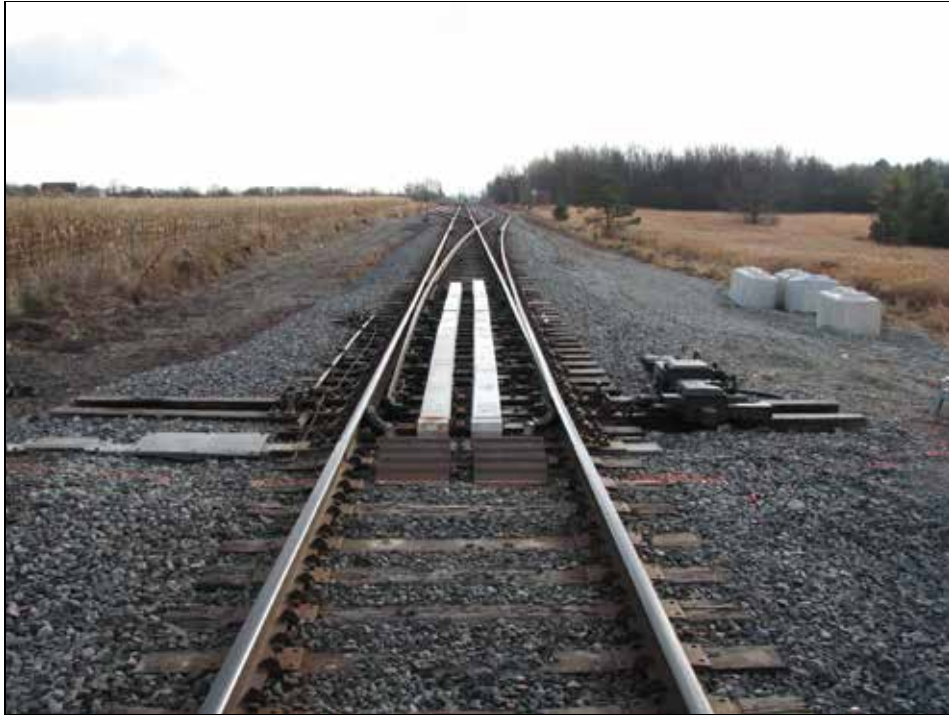
Photo 5. Branchement nord de la voie d'évitement Teston à Vaughan, Ontario
