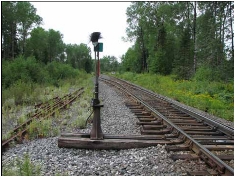
Photo 1. Appareil de manoeuvre en position normale du branchement JM33
