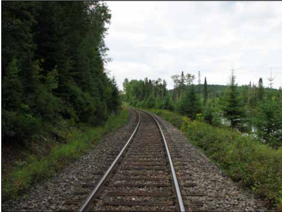
Photo 2. Emprise ferroviaire dans la courbe, à l'approche de l'aiguillage nord
