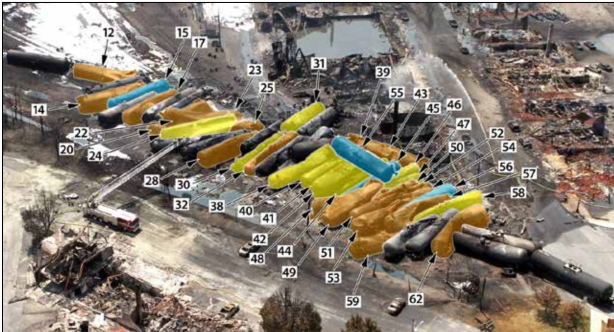
Photo 19. Wagons-citernes dont la coque a été perforée (la couleur indique la grosseur relative des perforations : orange=grosse perforation, jaune=perforation moyenne, bleu=petite perforation). La grosseur relative des perforations est indiquée à l'annexe B.
