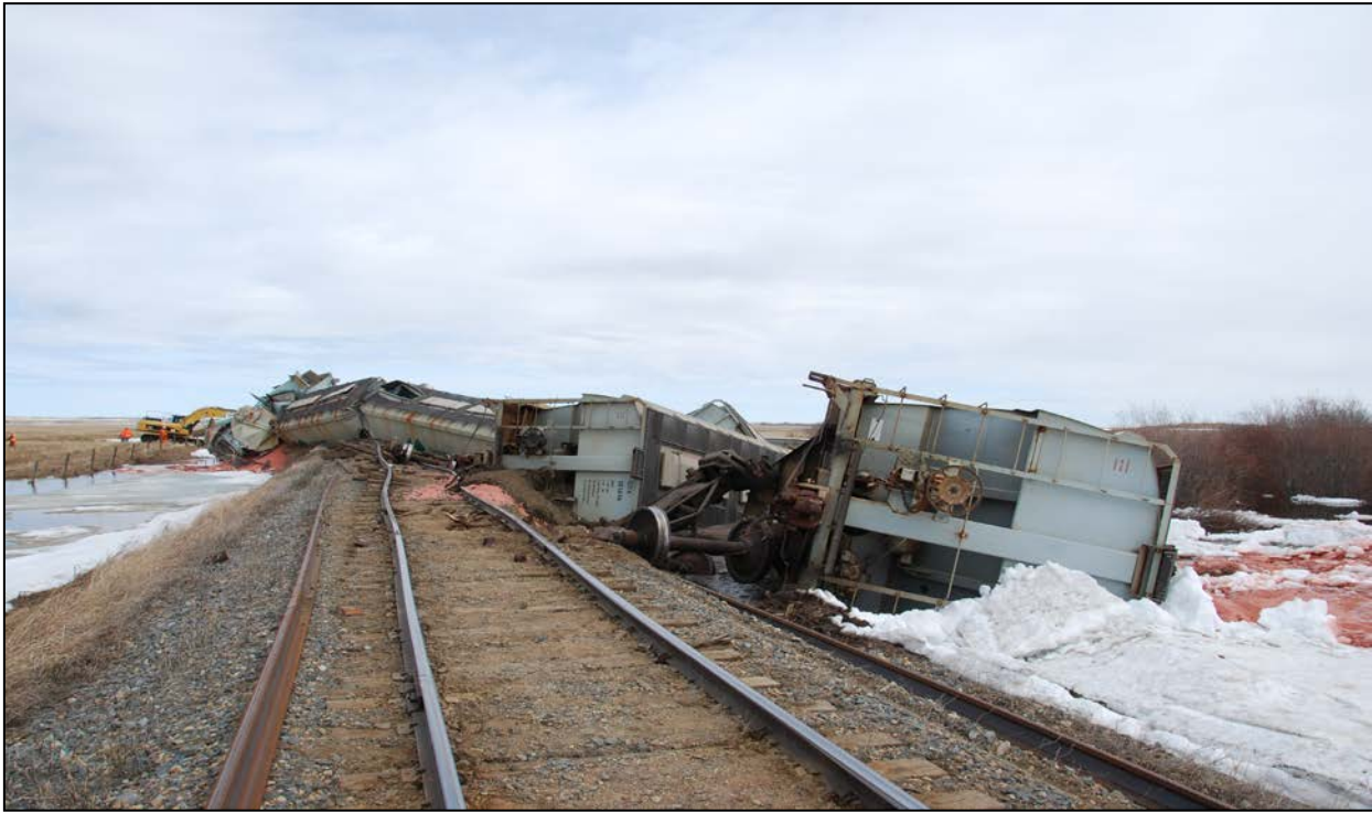
Photo 1. Vue vers l'est du site de déraillement
