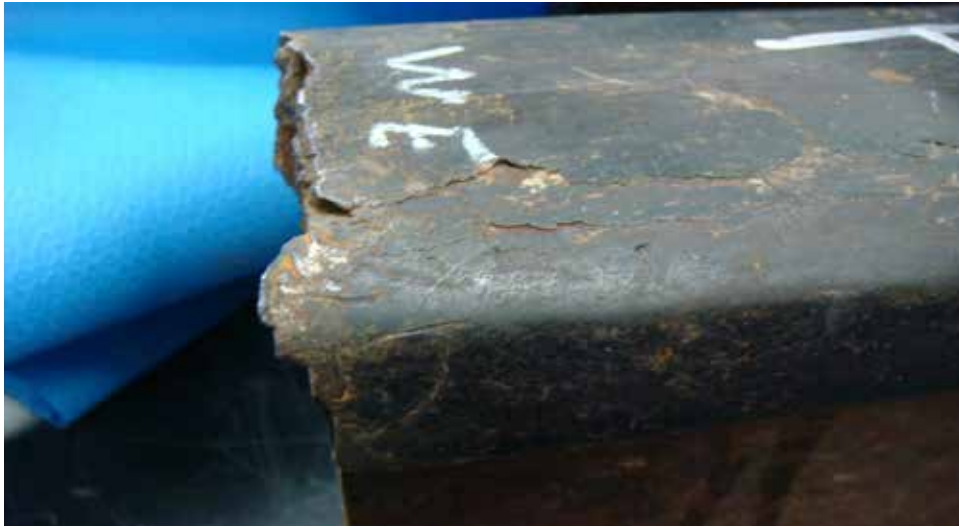
Photo 5. Condition de la surface du rail
