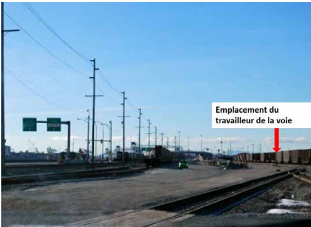
Figure 4. Vue de l'emplacement des travailleurs de la voie (aiguillage ELN4X) depuis le passage à niveau sur la branche est (554 pieds)
