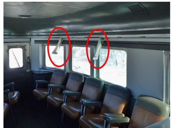
Figure 8. Panneaux du plafond partiellement détachés sur VIA 8711 (Source : BST)
