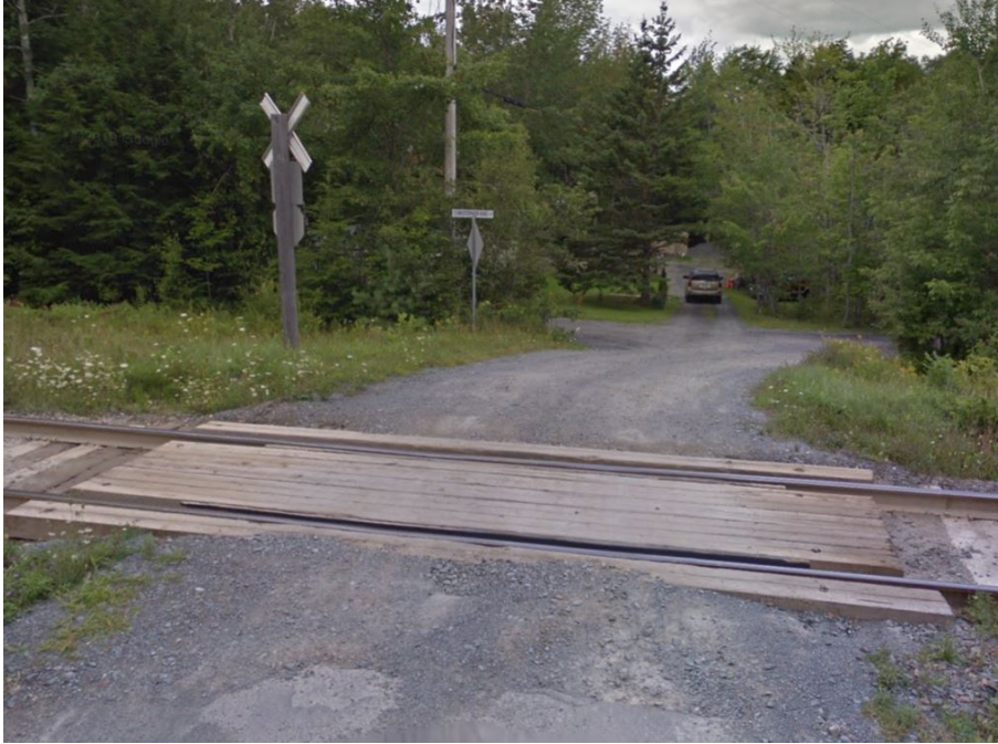
Figure 3. Vue vers le nord de la surface de croisement (Source : Google Maps Street View)
