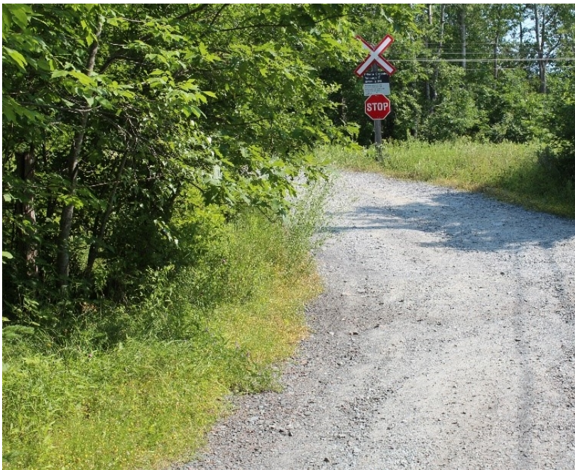
Figure 4. Abord en direction sud du passage à niveau (Source : BST)
